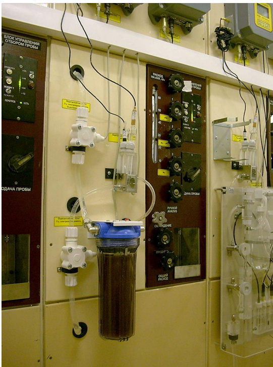
Датчики приборов АХК на панели УПП, КТЦ Сакмарской ТЭЦ
